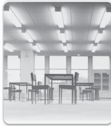
Lineare Vorschaltgeräte für Leuchtstofflampen
